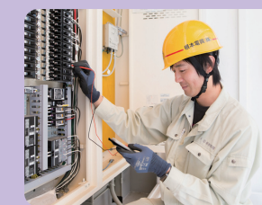
安全に配慮し、配電盤を確認します
