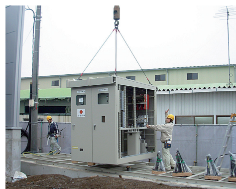
大型クレーンで吊って受変電設備の設置
