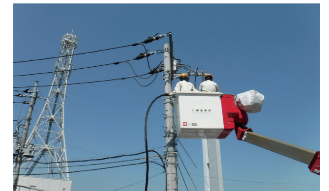
施工事例 常陸太田市本庁舎受変電・非常用発電設備電気工事の様子(写真提供：根本電興株式会社)
