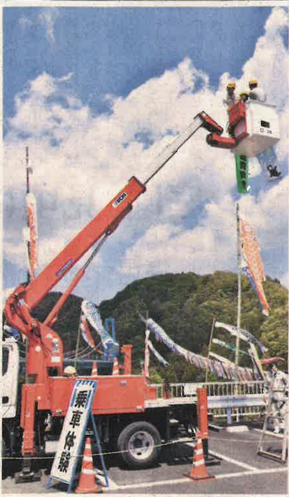
高所作業車に乗ってこいのぼりの泳ぐ姿を楽しむ 観光客＝常陸太田市天下野町の竜神大吊橋駐車場
